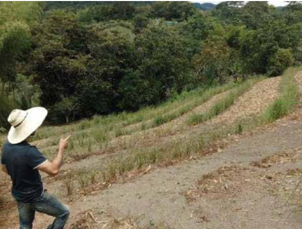
Barrera de vetiver para el control de la erosión
