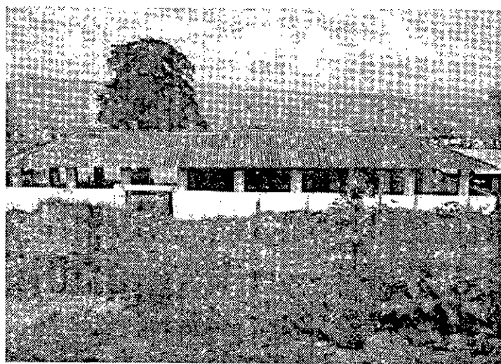
Matadero municipal de La Cumbre. Foto tomada por el autor.
