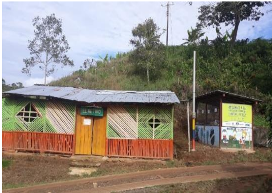
Caseta y ECA Vereda El Retiro
